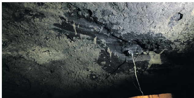
Kuva vesiteistä ennen pintakäsittelyä.
